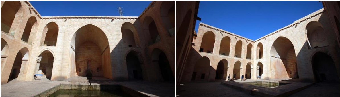
Görsel 3.4,5. Kasımiye Medresesi eyvan-havuz ilişkisi
